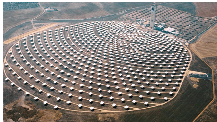
ENERGIA DO SOL No sul da Espanha, a primeira usina solar da Europa ajuda a reduzir as emissões de gases
